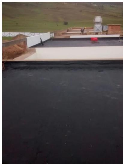
**Conjunto La Sabana Felicidad** - Impermeabilización fachadas, emboquille requerido, cambio de piezas, aplicación de hidrófugo, sellos de ventanearía y limpieza de vidrios – impermeabilización de jardineras y cubiertas con membrana PVC
