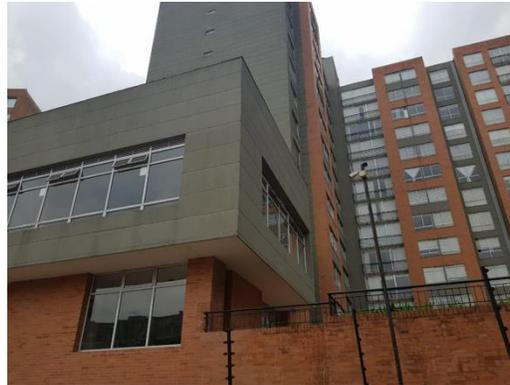
**Conjunto Gran Reserva de Toscana** - impermeabilización fachada en ladrillo con todo el procedimiento - aplicación pintura Koraza – emboquille, sello y cambio de piezas fachaleta sobre fachada.
