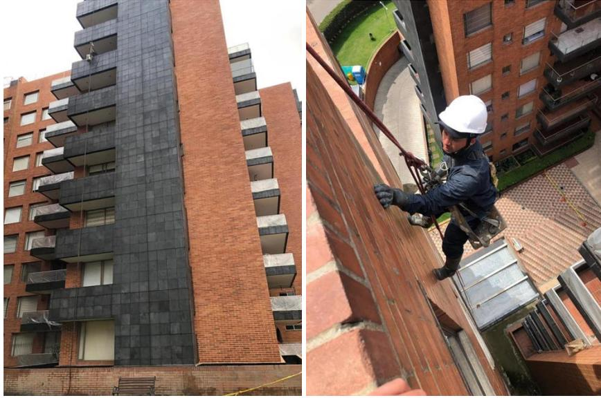
**ALPINA** - aplicación de poliuretano, tratamiento de fisuras e imprimación de la superficie con epóxico barrera de vapor y mejorador de adherencia.
