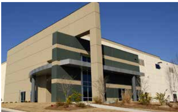
Exteriores en concreto, ladrillo, textura o pintura.
